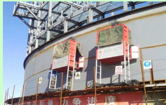
大型贮槽自动横焊机
