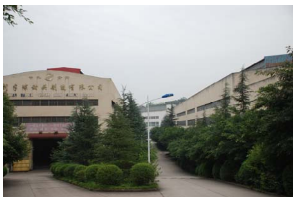
公司厂区一角
