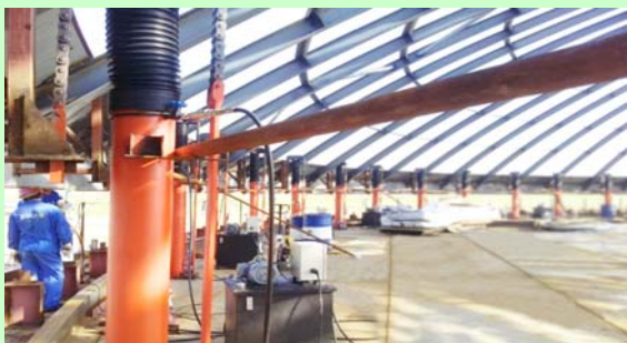
大型贮槽倒装用液压顶升装置
